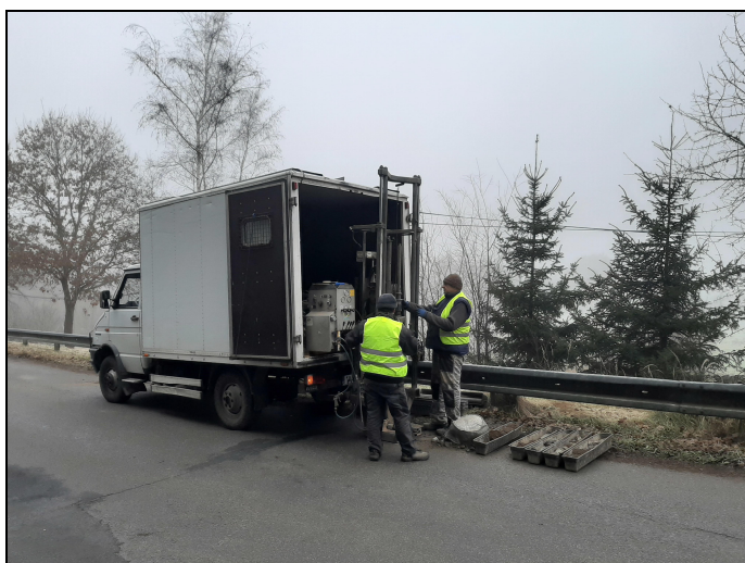
foto 6: Realizace jádrového vrtu J2
